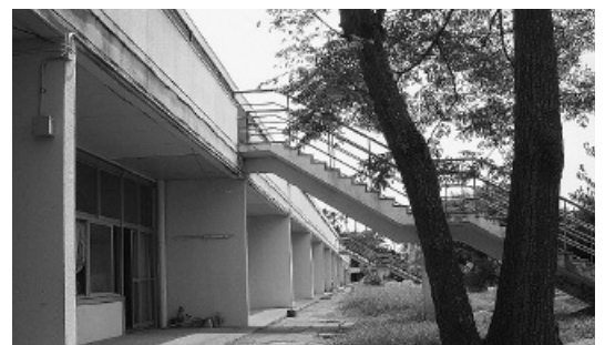
耐震改修工事予定の北条小学校校舎
