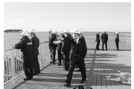
建設中の海辺の広場「展望デッキ」
