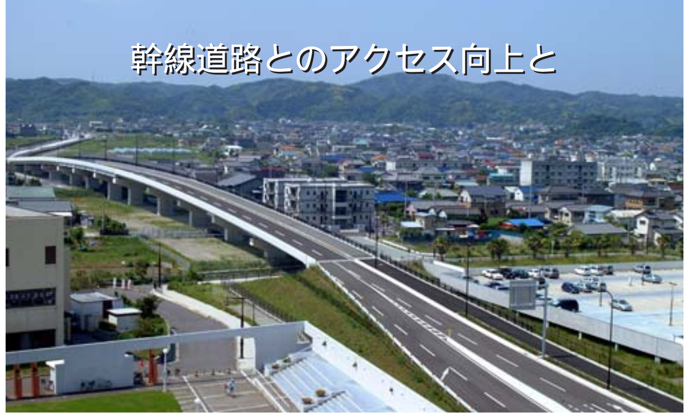
国道410号北条バイパスの南総館山大橋（南総文化ホール屋上から撮影）
