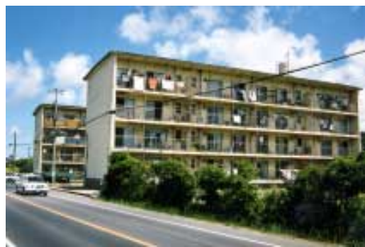
那古市営住宅
