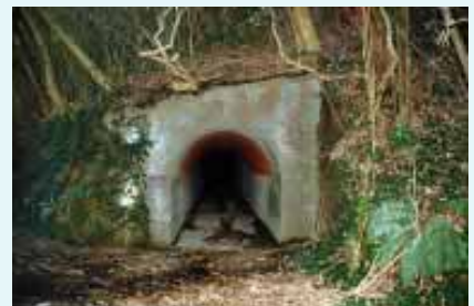
▲隧道式の砲側庫入口。迷彩が施され、内部にはレンガが貼られている。
