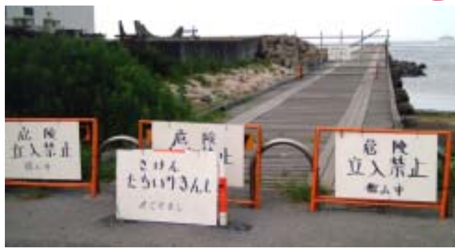
立入禁止の館山 棧橋
