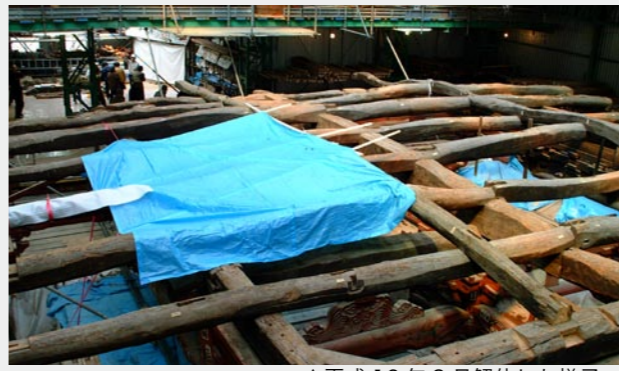
▲平成16年3月解体した様子
