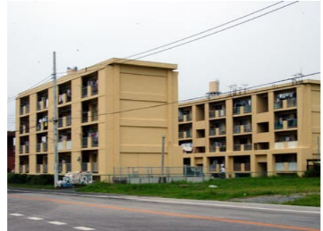
▲船形市営住宅
