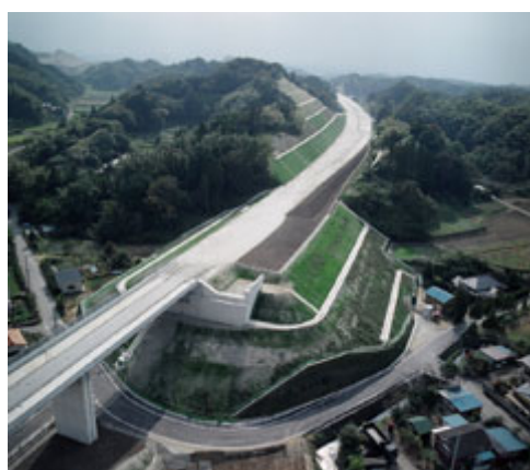
▲県道と立体交差(染川橋)
