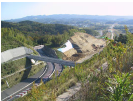
▲君津インター付近の工事
