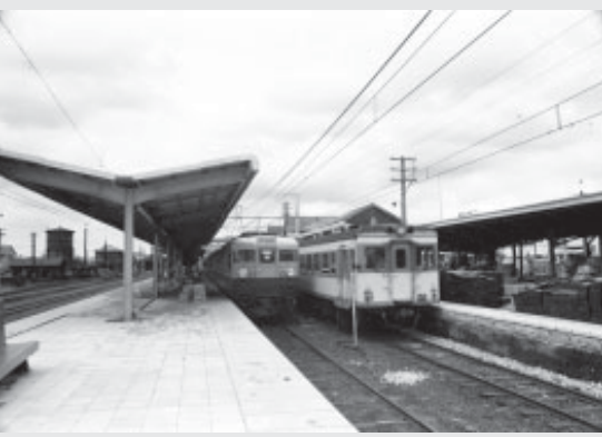
電車試運転の様子。ディーゼルカーに比べ電車は床が高いため、ホームを高くする工事を行った。左端に見えるのは蒸気機関車のための給水塔。昭和44年6月25日/館山駅
