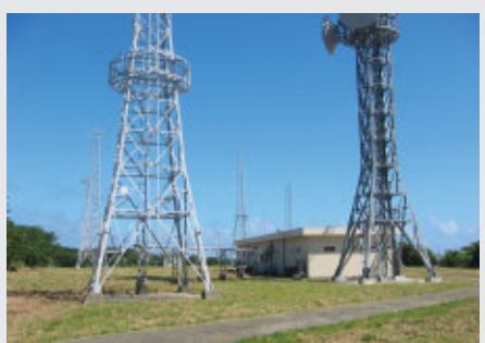
▲海上保安庁第3管区海上保安部白浜通信局
