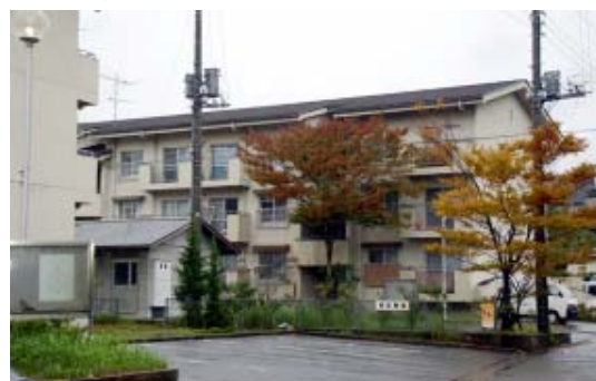
▼真倉市営住宅
