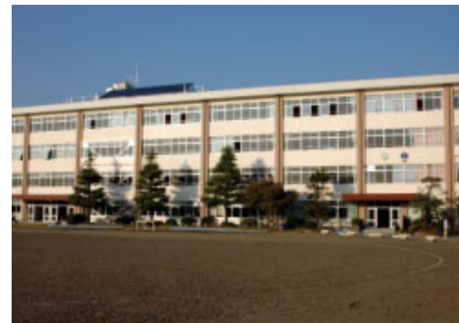
第二中学校の校舎を改修
